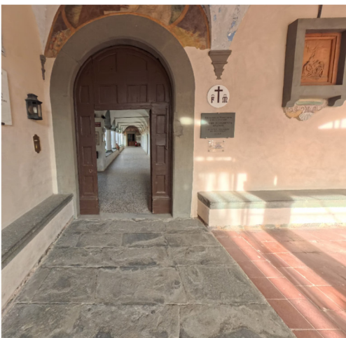
13 accesso chiostra Convento
